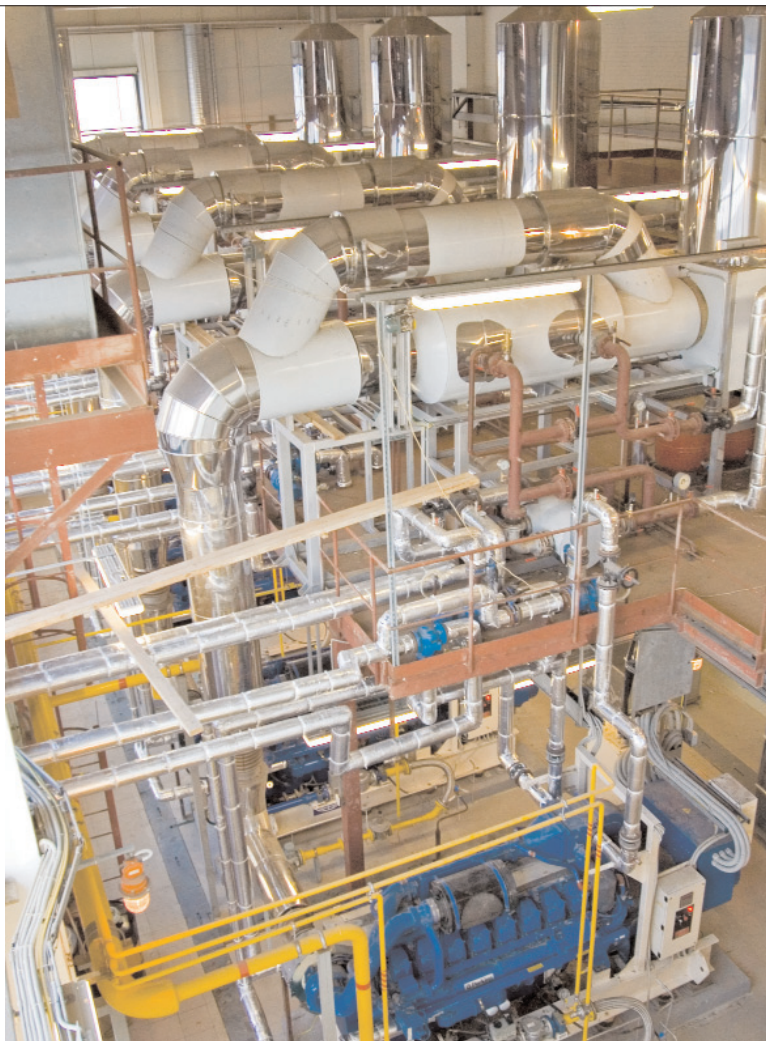
Фото 2. Машинный зал теплоэлектро- станции
